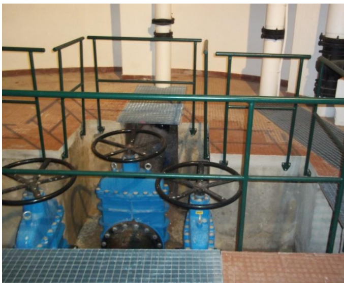
Instalação de proteções coletivas (SAA Grândola)
