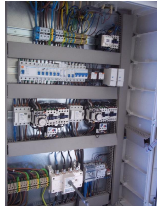
Substituição de todos os quadros elétricos do SAA de Melides
