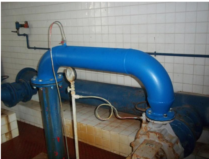
Substituição tubagem de compressão do grupo 3 da EE de Grândola
