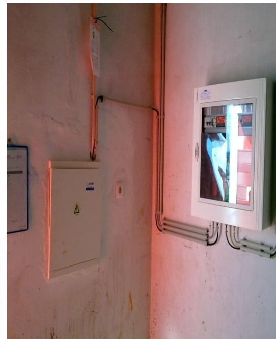
Instalação de sistemas de telemedida (todos os reservatórios)
