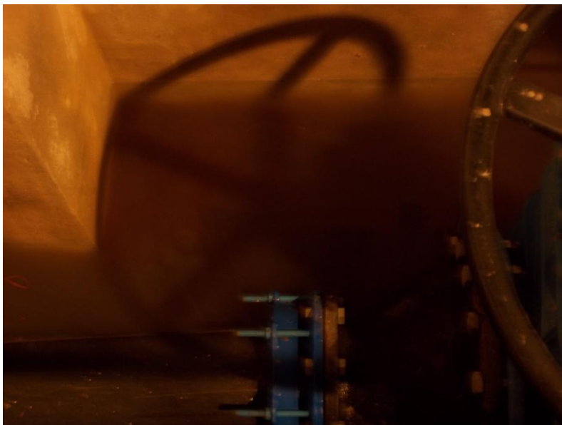
Limpeza e higienização de reservatórios
