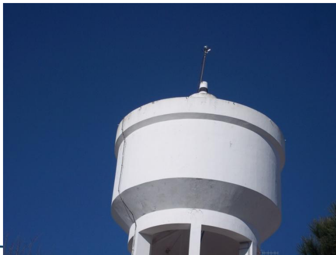
Instalação de sistema de comunicações rádio (SAA de Canal Caveira)
