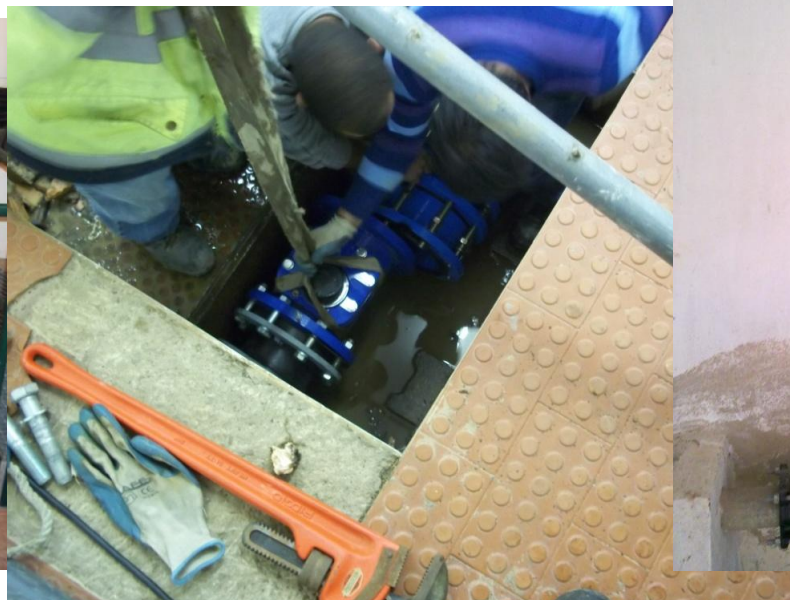
Instalação/substituição de medidores de caudal
