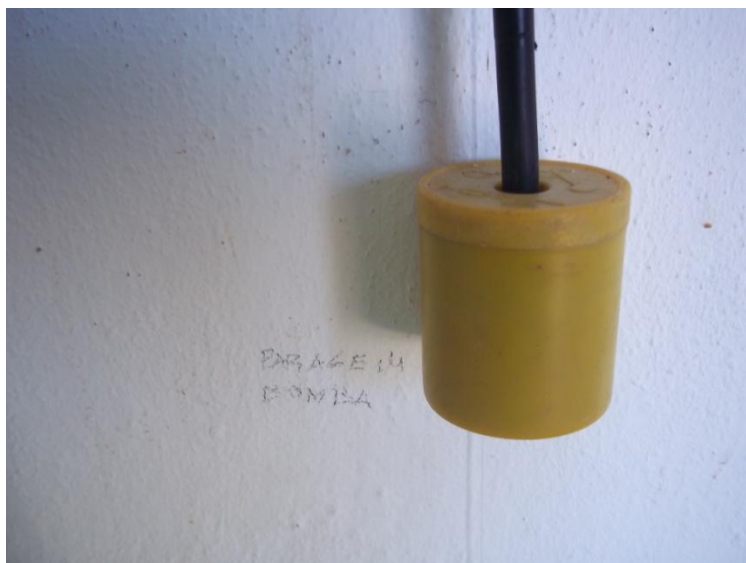
Instalação de mecanismos para indicação de nível em reservatórios
