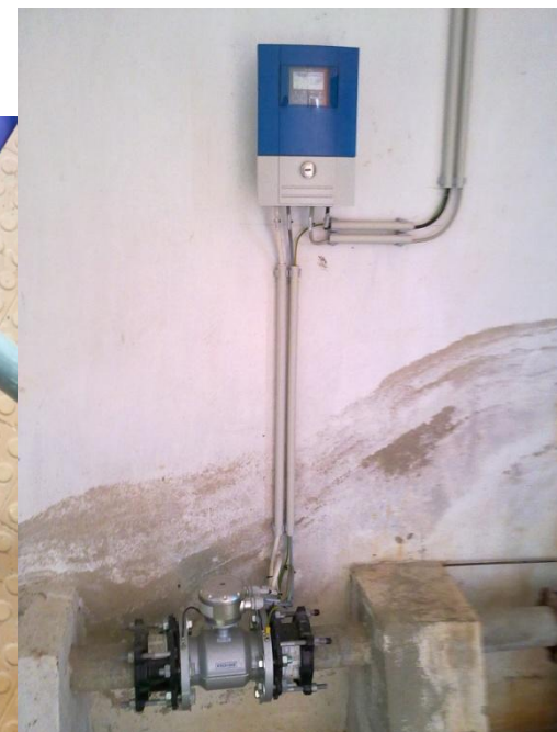
Instalação/substituição de medidores de caudal
