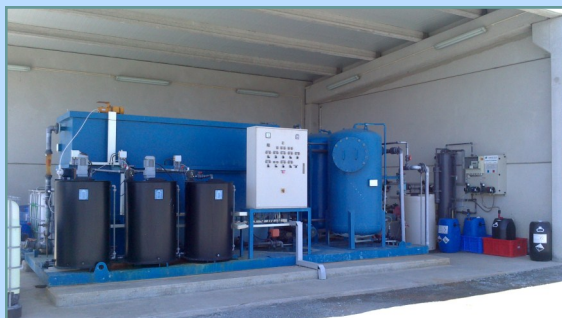
Estação de Tratamento
