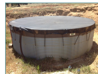
Reservatório de água bruta
